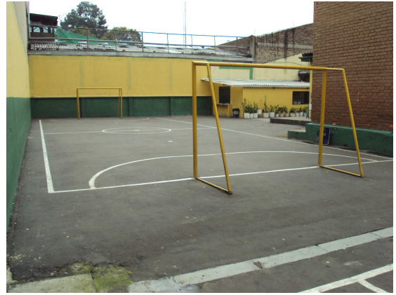
Área intervenida de la cancha múltiple
