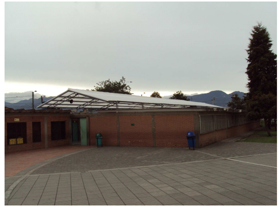
Área intervenida con la instalación de la cubierta
