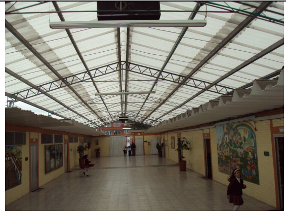
Vista interior de la nueva cubierta
