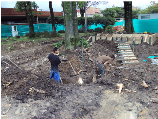
Alistado de la cimentación, construcción de jardineras
