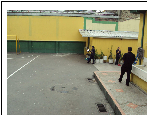
Vista del acabado en asfalto de la cancha múltiple
