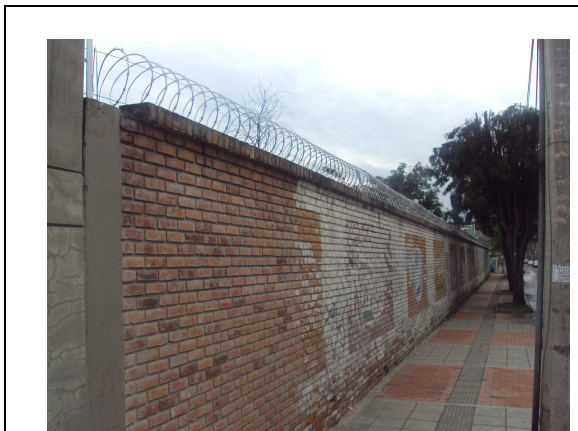
Instalación de concertina por el contratista (sin retirar)
