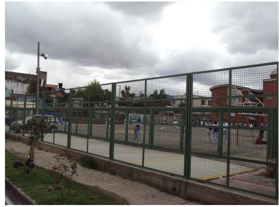
Construcción doble malla de cerramiento y placas
