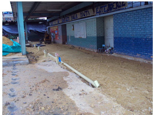
Aérea pagada en el corte 01 sin intervenir
