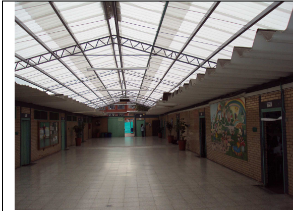
Vista interior de la cubierta instalada inicialmente
